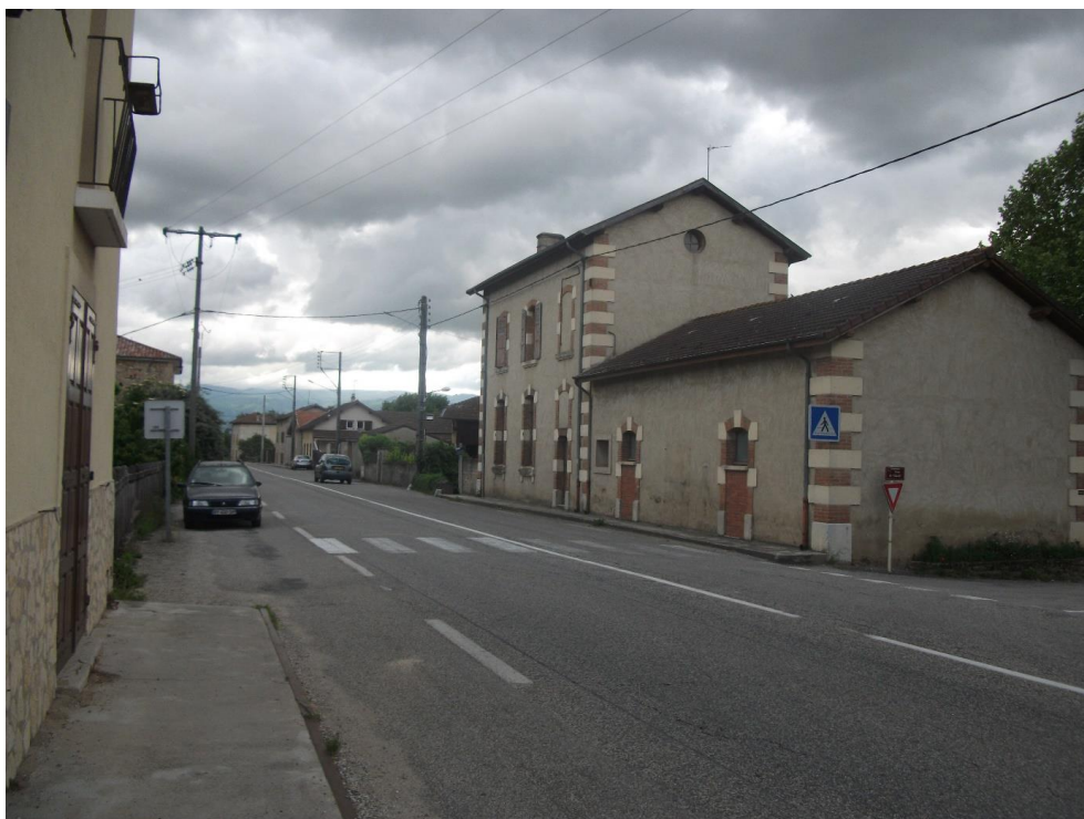
Photographie 57 : Traversée de la Baudière
