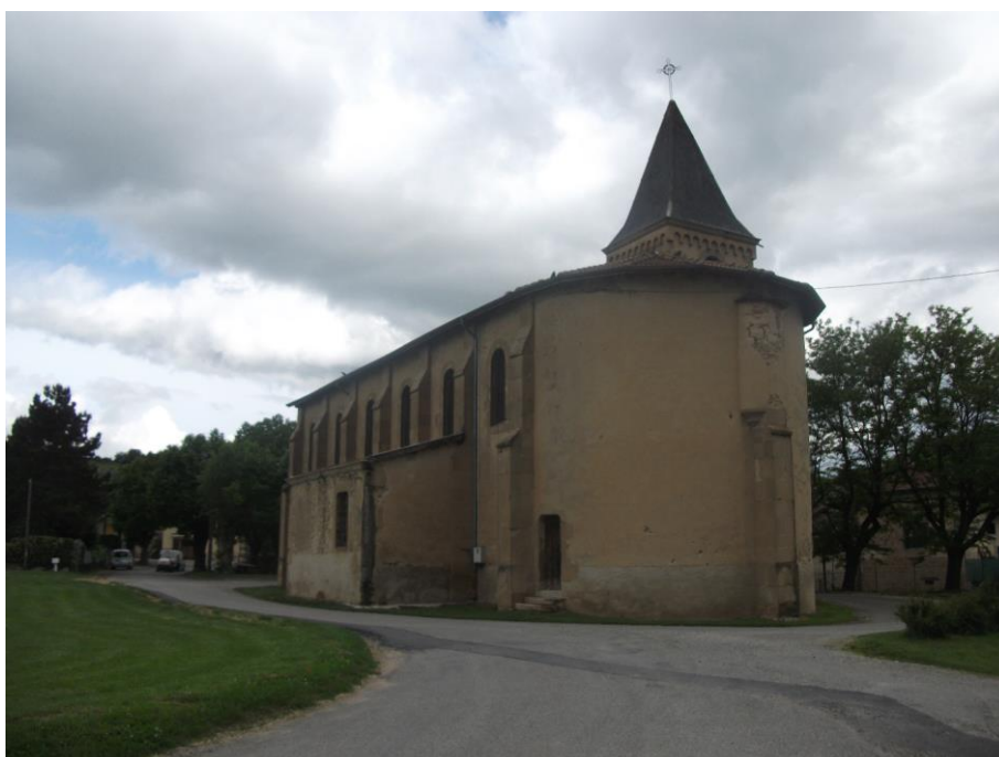
Photographie 24 : Vues sur l'Eglise de la Baudière
