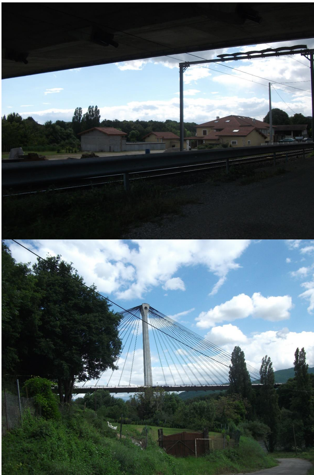
Photographie 16 : L'ouvrage est perçu différemment à l'échelle du piéton notamment dans le quartier des Bouquets en-dessous du pont
