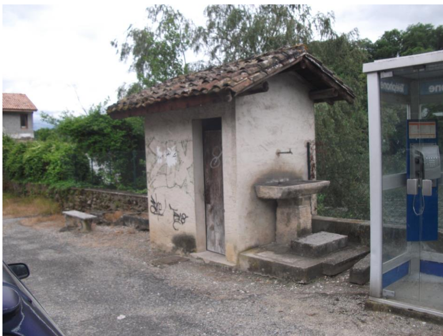
Photographie 53 : Le parking nécessite d'être réaménagé
