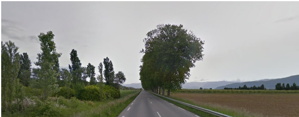
Photographie 17 : Entrée Ouest
