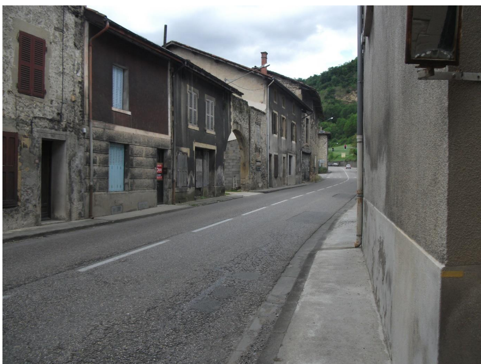
Photographie 58 : Les trottoirs des Fauries sont étroits et dangereux
