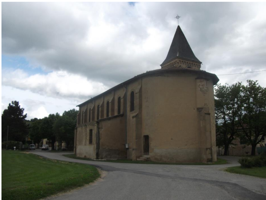
Photographie 24 : Vues sur l'Eglise de la Baudière
